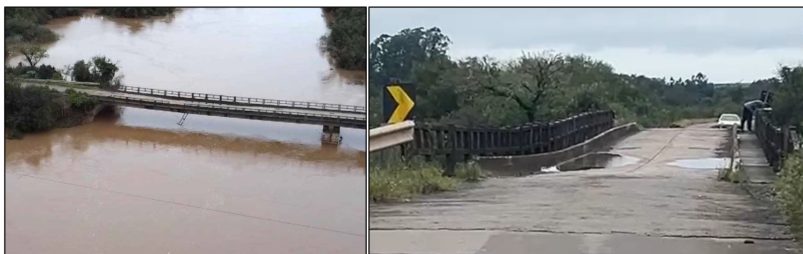
Fig. 4: Imagens lateral e frontal da ponte de concreto sobre o rio Ibicuí-Mirim, em 30/04/2024.
