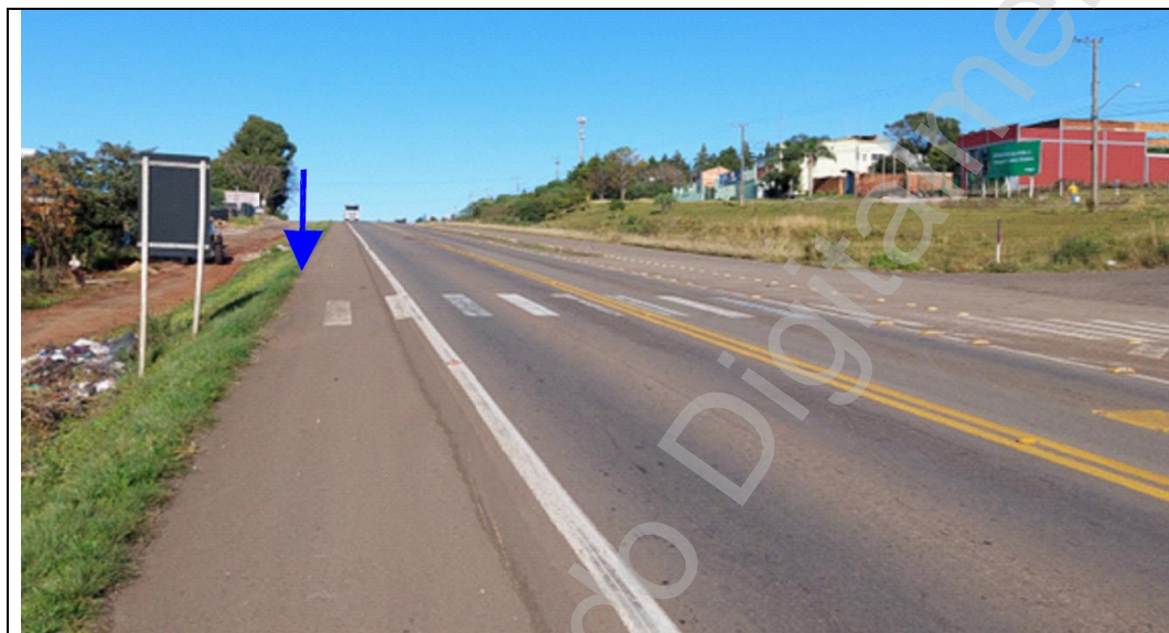
4.2.1) Vista em direção a Passo Fundo – Fiscalização do sentido Passo Fundo/Coxilha Localização para Implantação do Medidor: Lat 28°13'30.71"S Long 52°22'03.75"O ERS 135 km 9 + 100 metros
