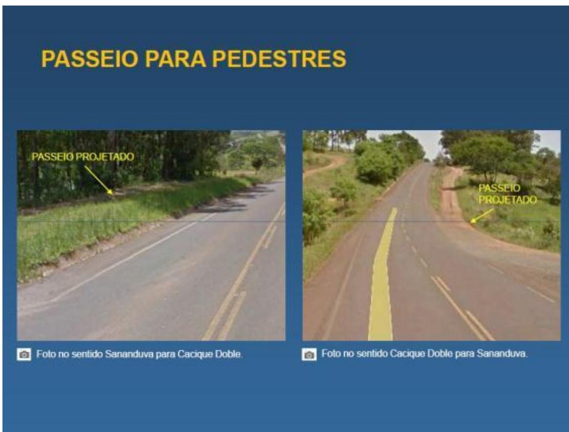
Figura 69 - Proposta de alargamento de parte da via com criação de passeio para pedestre
